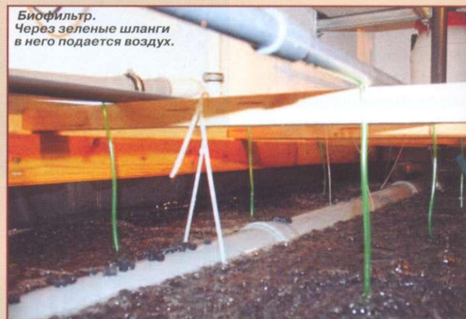
По серой трубе большого диаметра в биофильтр поступает вода из барабанного фильтра.
